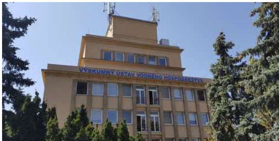
Obr. 1. Sídlo Výskumného ústavu vodného hospodárstva v Bratislave. Zdroj: Archív VÚVH
