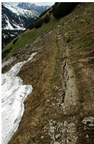
Obr. 2: Dilatačné trhliny pozdĺž turistického chodníka v Zadných Meďodoloch Foto: J. Hreško, 14. 5. 2009
