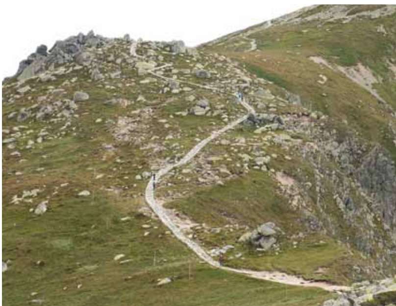
Obr. 2. Novovybudovaný turistický chodník so spevneným skalným povrchom aspoň čiastočne zabraňuje ďalším nežiaducim eróznym procesom. Znamky po erózií sú však na svahu stále zreteľné, ale v menšom rozsahu (bezmenný kopec nad Lukovou dolinou, medzi Konským a Chopkom, 2014). Foto: Tatiana Hrnčiarová
