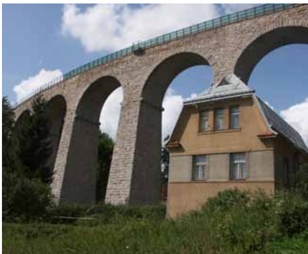
Obr. 1. Smržovka – železniční viadukt z roku 1894 (2010). Foto: Jaromír Kolejka
