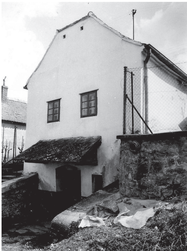
Trvalo obývaná búda (Hliníky, č. p. 6 370) s pracovnými a skladovými priestormi na prízemí a v pivnici. Fasáda si zachovala pôvodný štýlový výraz z konca 19. storočia. Foto: B. Brtková, 1997
