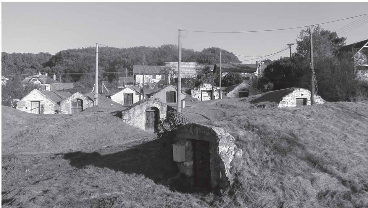
4. Vchody do vínnych pivníc v obci Veľká Trňa. Foto: P. Škulavík, 2005
