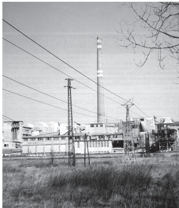
Starý magnezitový závod Košice-Ľahanovce. Foto: archív redakcie
