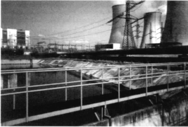
3. Retenčná nádrž na odpadové vody z prevádzky JE v Jaslovských Bohuniciach
