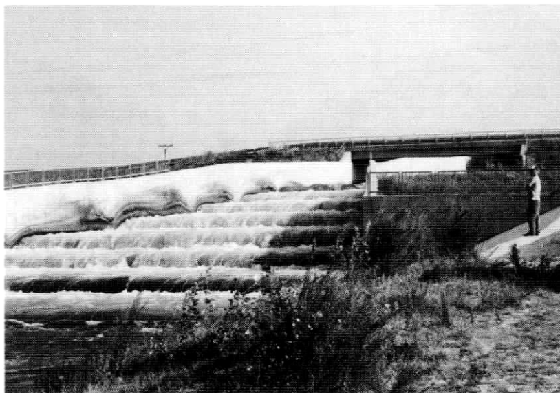
1. Kaskáda pod objektom na zásobovanie systému ramien medzi Dobrohošťou a Gabčíkovom vodou z prírodného kanála vodnej elektrárne
