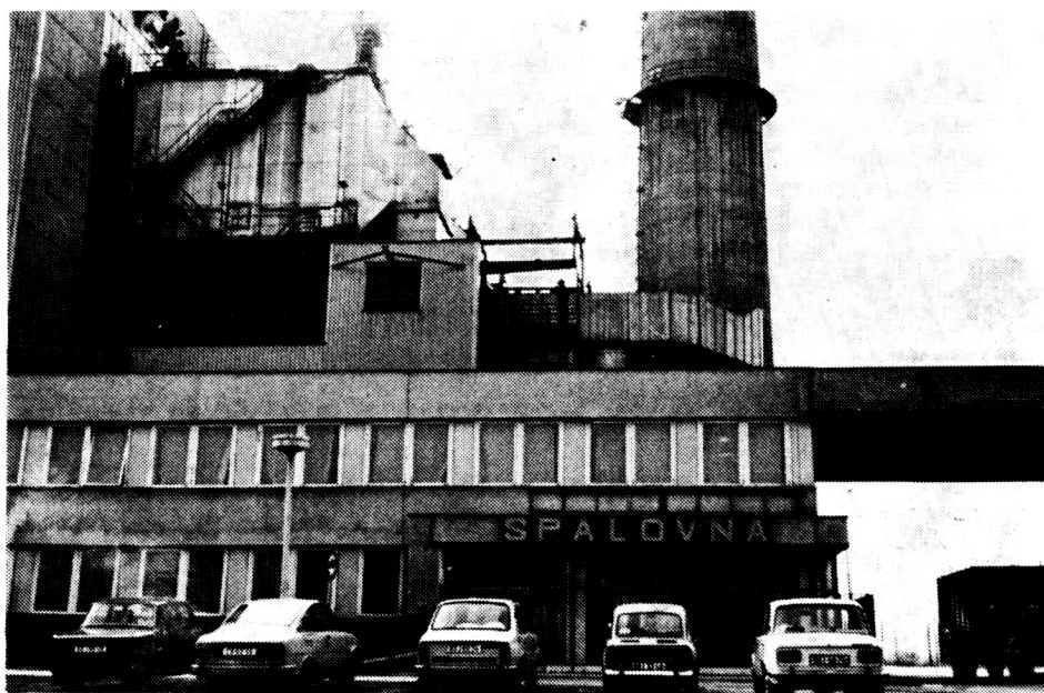
Obr. 4. Spaľovňa odpadov hl. m. SR Bratislavy.
